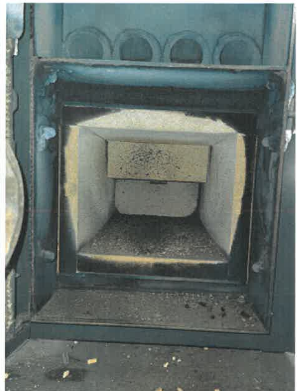
Rysunek 9 Elementy ceramiczne komory spalania
