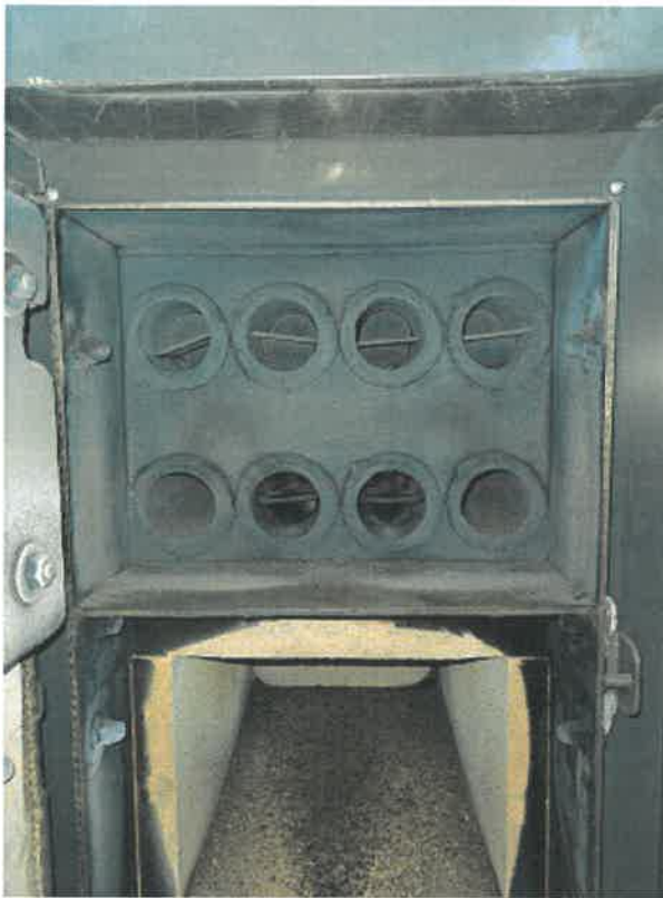
Rysunek 8 Wymiennik i zawirówywcze
